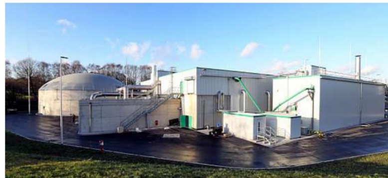
Mit der überschüssigen Abwärme aus der Biogasanlage der AHE in Witten soll künftig der Restmüll des Kreises getrocknet werden FOTO: FISCHER / FFS
